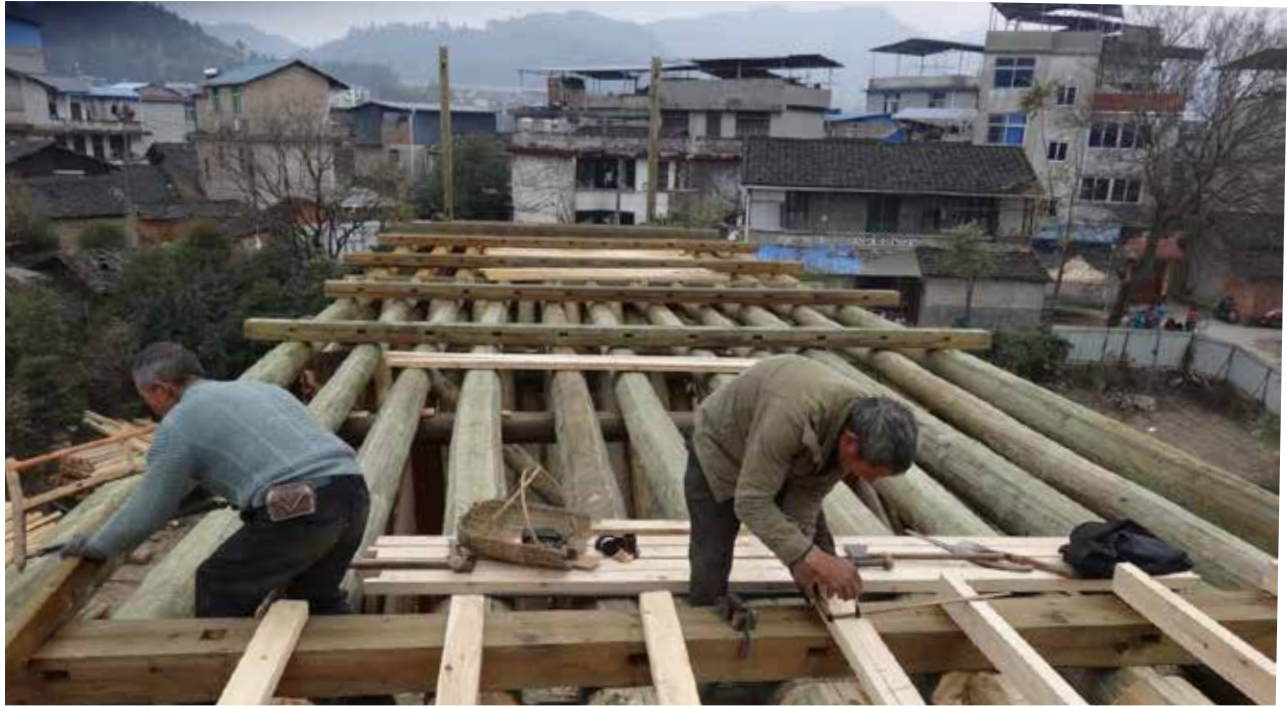
Perinteisen puusillan jälleenrakentamista Kiinassa. Yuqing Bridge, Wushan.
