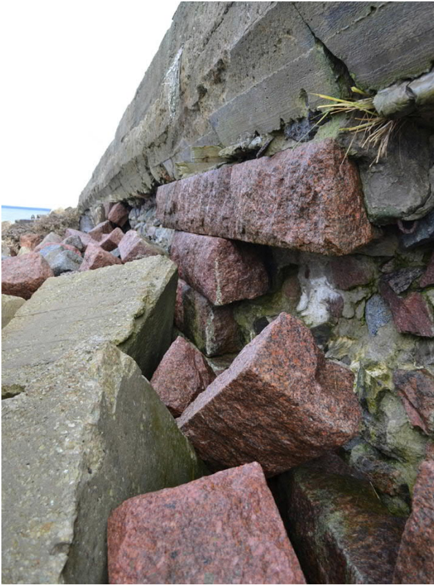
Vasemmalla: Upinniemeltä peräisin olevilla graniittiharkkoilla vuorattu aallonturkajan pohjoissivu. Oikealla: Graniittiharkkojen alin rivi Topeltpatarein linnakkeessa. Kuvat: Robert Treufeldt 2017 ja 2008.
