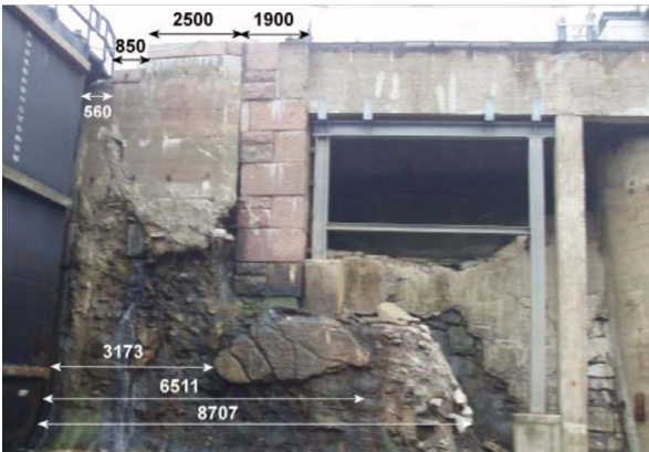
Kuvat 5-6. KAREG suunnitteli Suomenlinnan kuivatelakan uivan sulkuportin pohjoispielen vahvistamisen. Sulkuportit ovat 1700-luvulta. Kyseessä oli laivatelakan uloimman sulkuportin pohjoispielen betonisen, meriveden vaurioitaman ja pakkasrapautuneen seinän korjaussuunnittelu, korjaustyönaikainen valvonta ja ns. asiantuntijavalvonta. Projektin valmistumisvuosi oli 2012.
