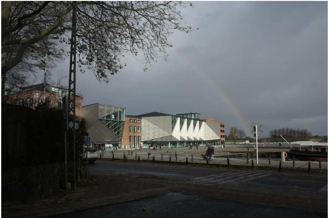
Entinen standardinomainen tehdasrakennus on saanut uuden tilaa, valoa ja varjoja luovan julkisivun. Sisällä on avarat kirjasto- ja kokoustilat. / Margaretha Ehrström
