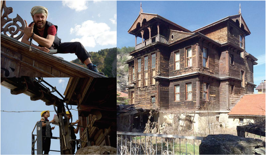
Mudurnun mittauskohde oli 1880-luvulla rakennettu paikallisen tradition mukainen kolmikerroksinen puutalo, Armutçular Konağı.
