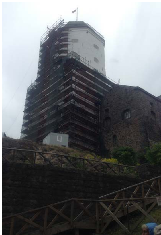
Viipurin linnan torni restaurointitelineineen
